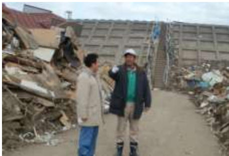
岩手県宮古市、10mの防波堤が崩壊した
