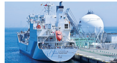
神戸港には既に水素基地が存在している
